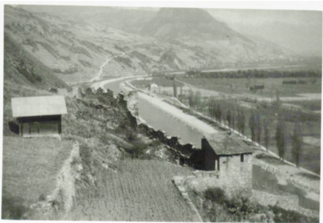
Vue de la porte de Covent depuis l'Ouest resp. depuis les rochers à l'extrémité orientale du plateau de Valère (F.-O. Dubuis 1959).
