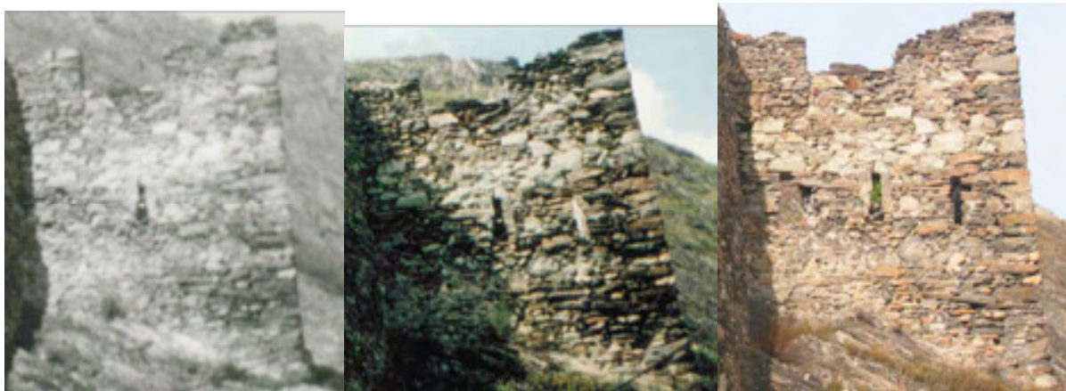
Le bastion vu depuis le Sud-Est. (1. F.-O. Dubuis 1959. 2. Fabrice Burlet été 1993. 3. idem 2009). Mis à part l'ouverture de deux des trois meurtrières, il n'y a heureusement que peu de pierres du couronnement qui sont tombées.
