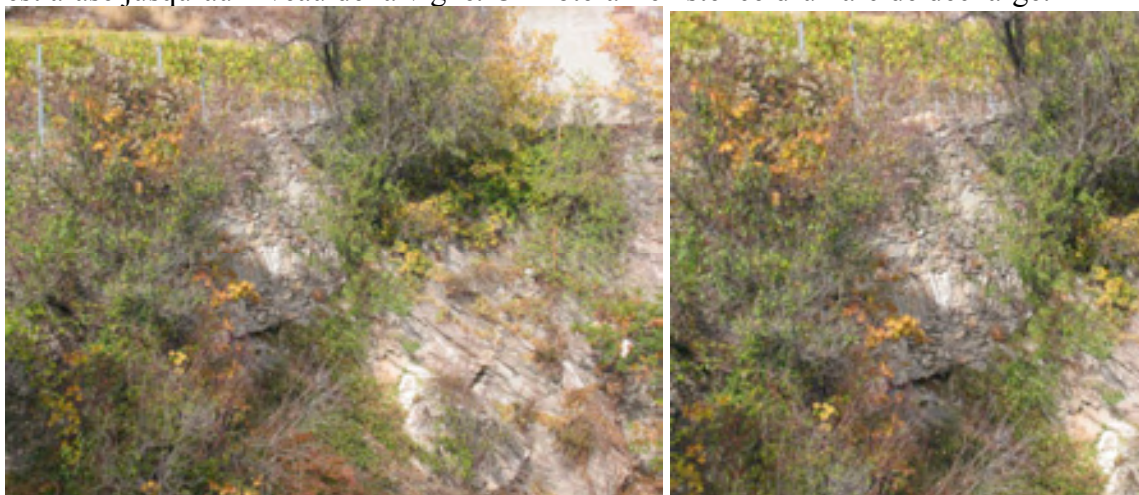
Le mur S1 et son arc de décharge (Fabrice Burlet 2009).
