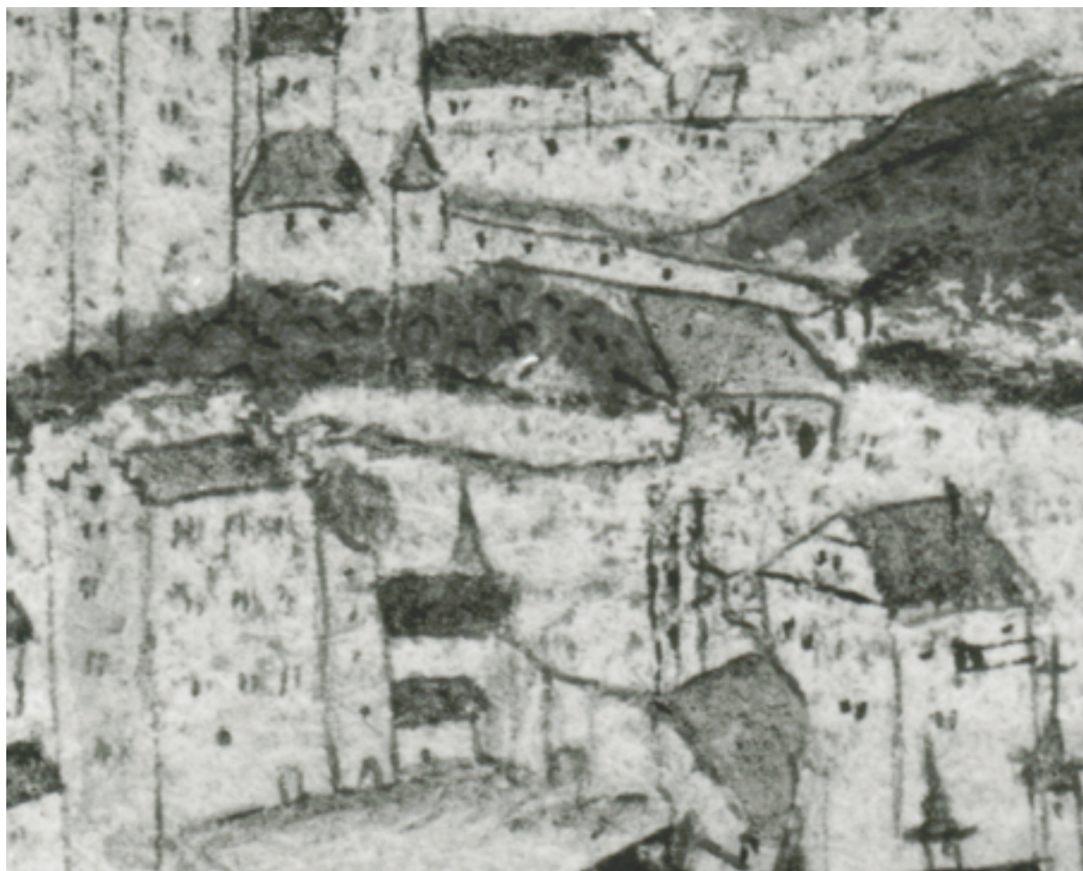
Vue sud avant l'incendie.
